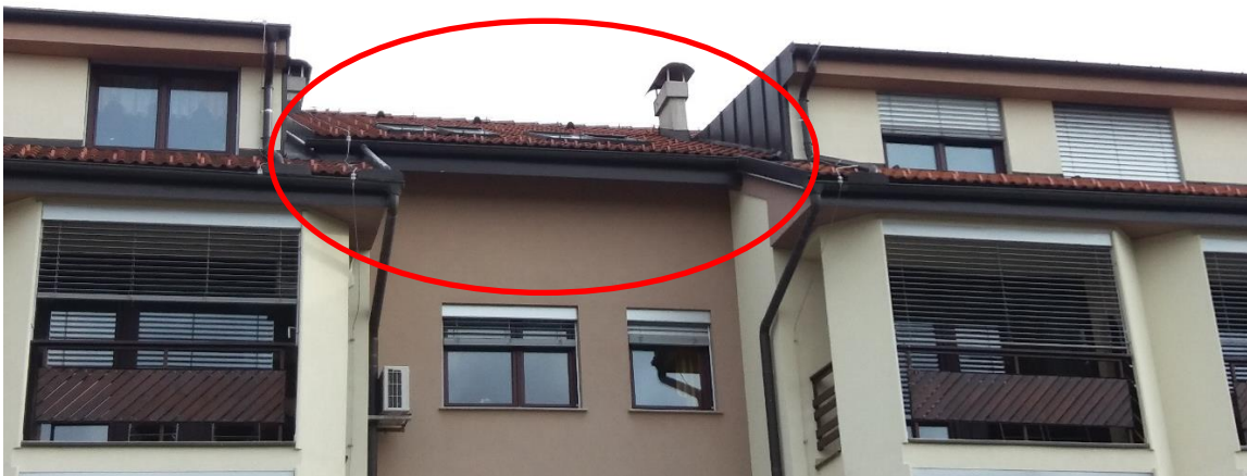
Obstoječe stanje – zahodna stran
